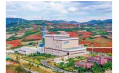
昆明三峰环保发电厂(1000吨/天)
