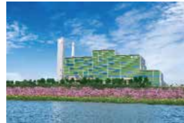
安徽六安环保发电厂(1200吨/天)
