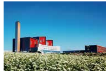
内蒙古赤峰环保发电厂(800吨/天)
