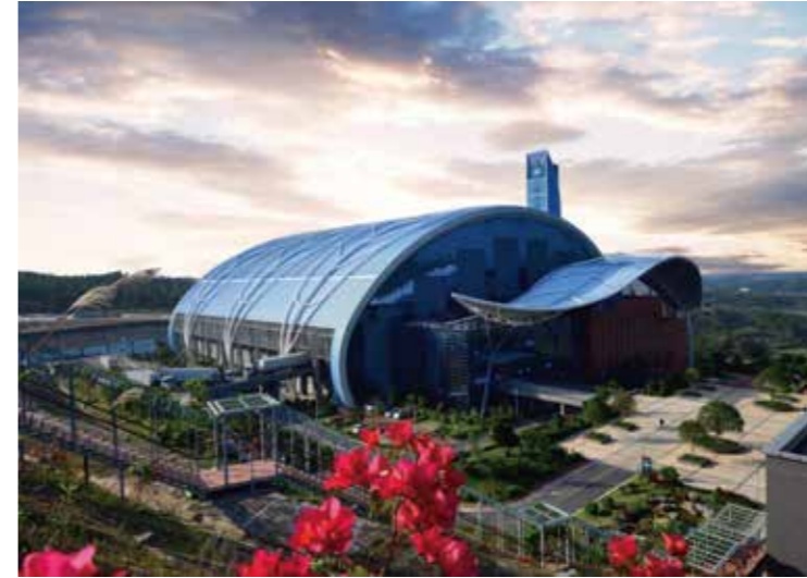
辐射东盟·南宁三峰环保发电厂(2000吨/天)
