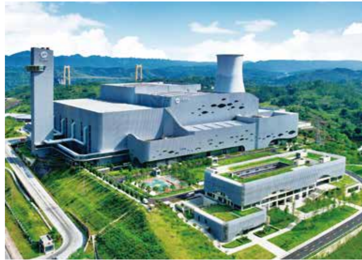
超低排放·重庆御临环保发电厂(3000吨/天)
