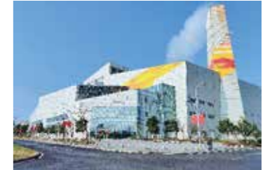
浙江绍兴环保发电厂(2250吨/天)
