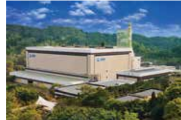
重庆丰盛环保发电厂(2400吨/天)
