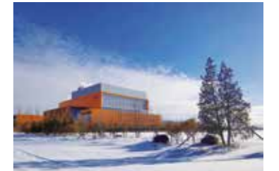
辽宁鞍山环保发电厂(1500吨/天)
